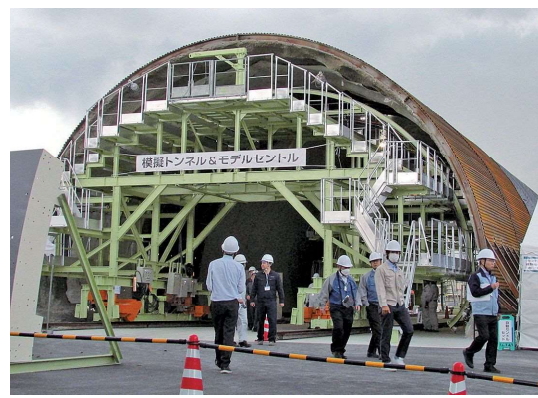
最新技術を見学できる模擬トンネルとモデルセントル
